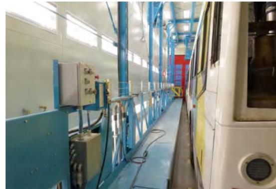
Figure 12 : Exemple cabine de peinture avec plateforme mobile
