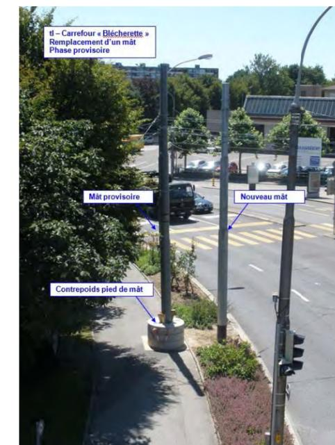
Figure 17 : Mât provisoire chez Transports Lausanne
